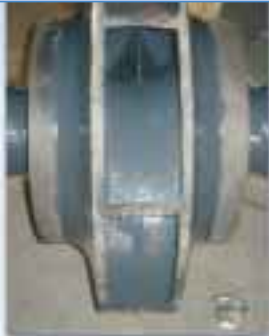
Трещины на лопасти были заделаны с использованием шпатлевки Loctite® Superior Metal. Loctite® Nordbak® 7227 Brushable Ceramic был применен в качестве второго слоя
